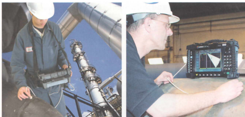
Рис. 5.83. Контроль сварных швов на нефтеперерабатывающем заводе.
