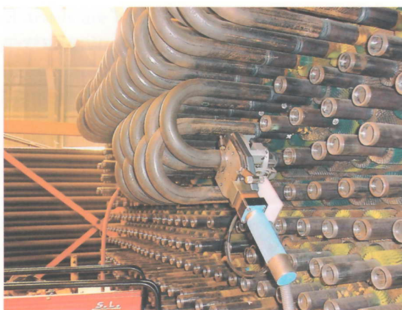
Рис. 5.82. Сканер, установленный на сварном шве для контроля в процессе монтажа
